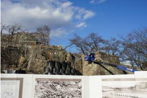
小峰城跡石垣復旧工事
